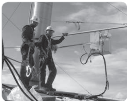
Figura 3.14. Montaje de las caja fría y caliente durante un monitoreo en chimenea.
